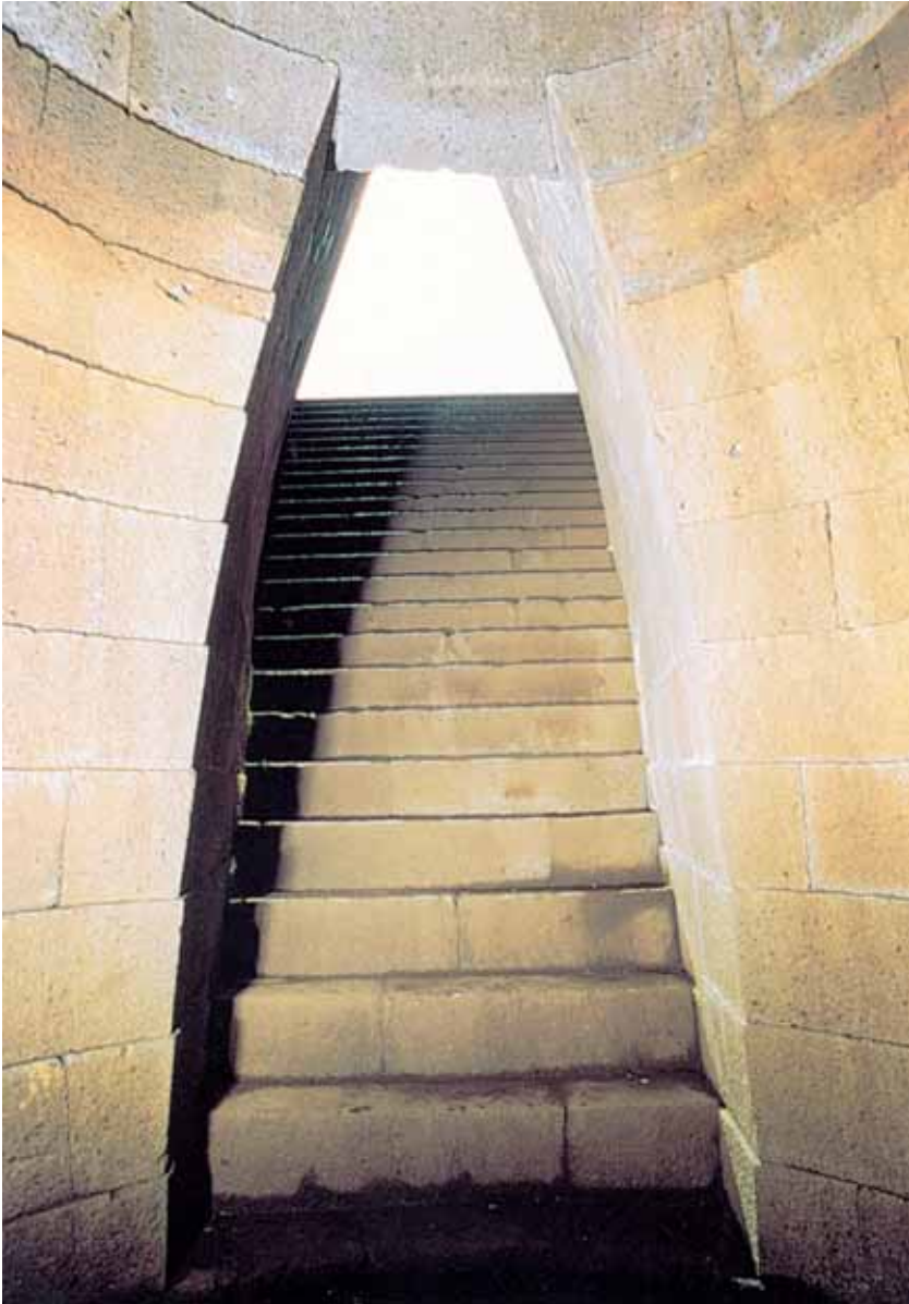
Fig. 15. La scala vista dall'interno della camera ipogeica.
